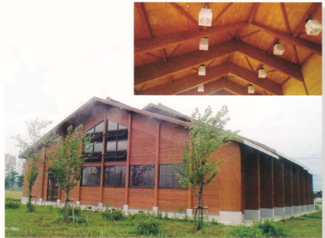
● 南部中学校武道館 富山県富山市 海老建築設計事務所
